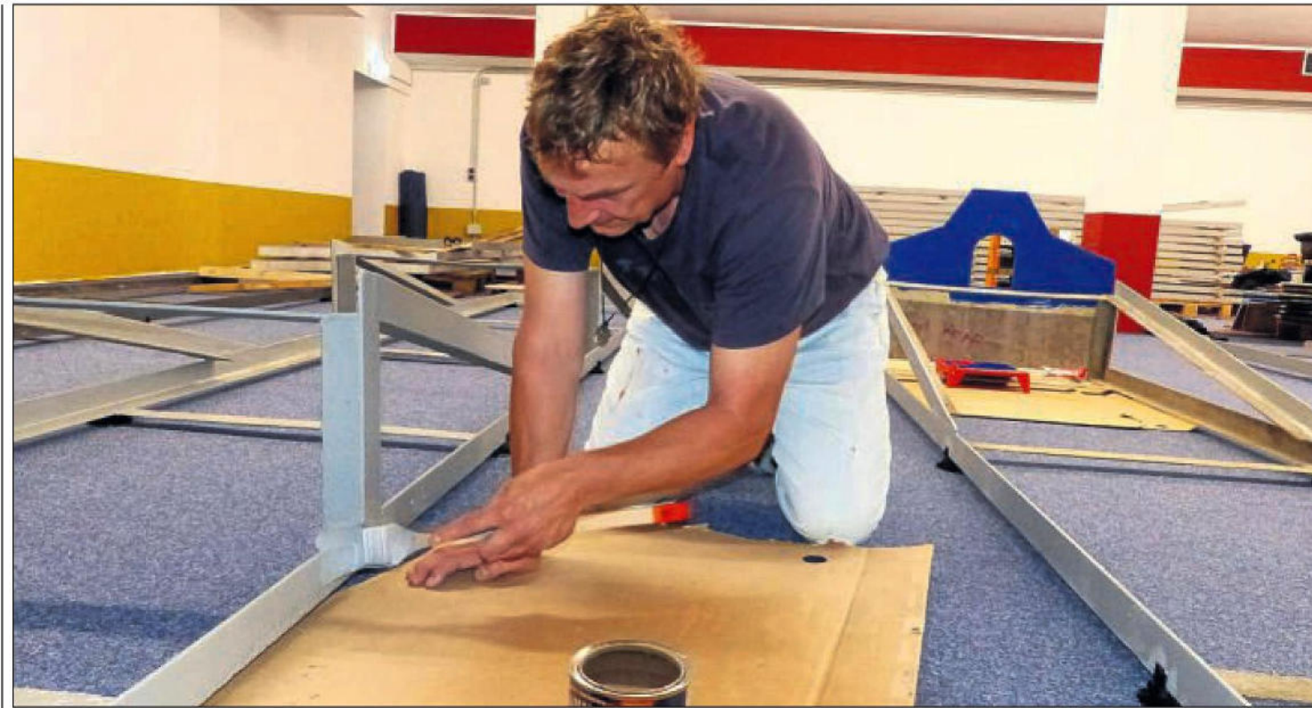
Die Stahlrahmen der 18 Bahnen wurden am Sonntag ins Gebäude gewuchtet. Dabei platzte ein Teil der Farbe ab, doch Sportwart Stephan Römer behebt derzeit die kleinen Makel. ▪ Foto: Holz
